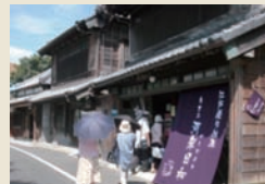
【重要伝統的建造物群保存地区】舟運で栄えたまち佐原は江戸優りと言われ、江戸から昭和初期の建造物を多く残している。
