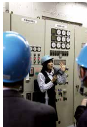
*所内の発電調整室
