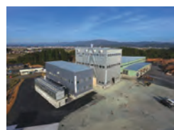
2018年12月1日に操業したもがみ木質バイオマス発電所
