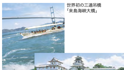
世界初の三連吊橋「来島海峡大橋」
